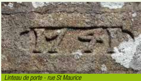
Linteau de porte - rue St Maurice
